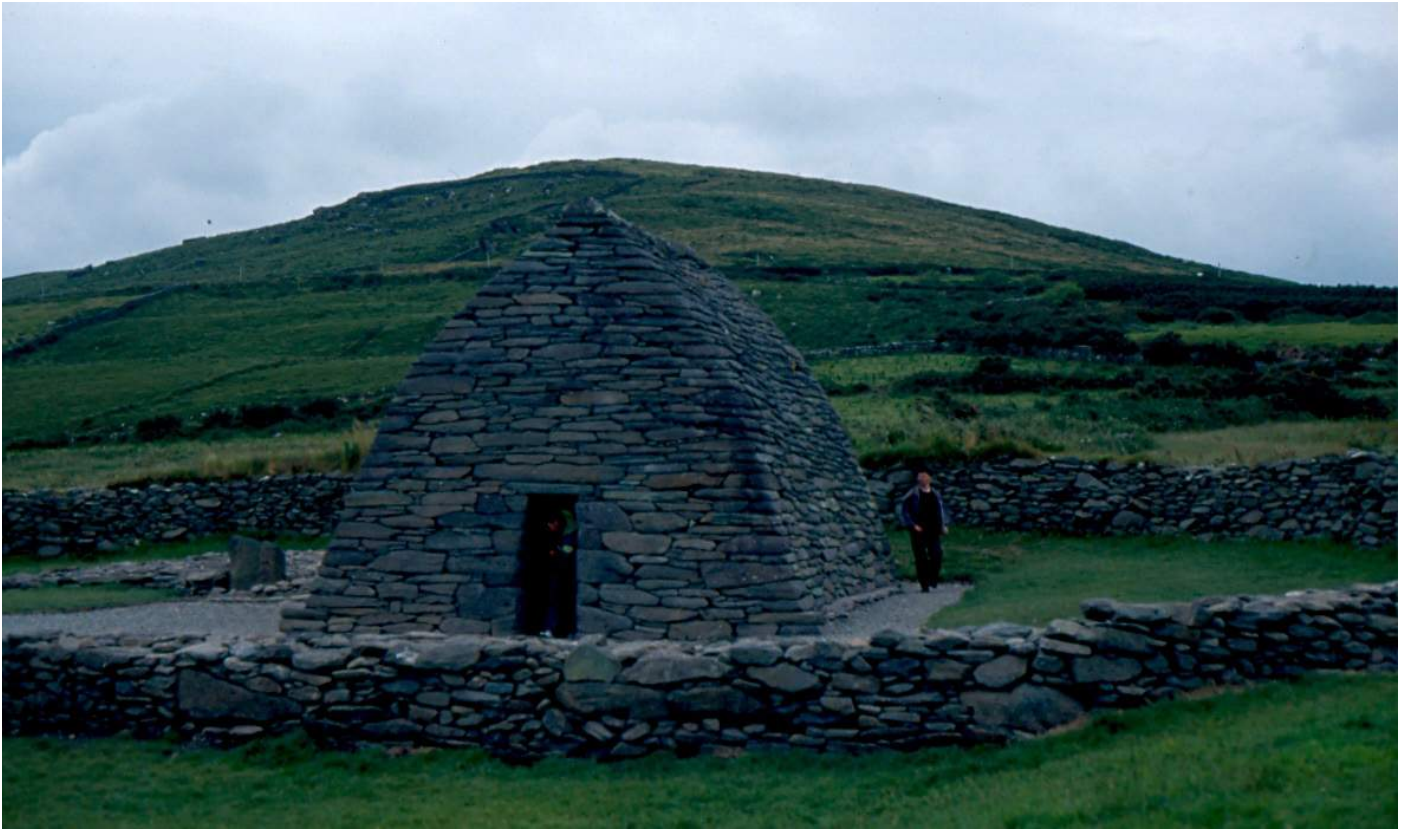
Oratoire de saint Gallarus, petit bâtiment du XII e siècle, en encorbellement, constitué de pierres taillées (Baile na nGall, Kerry).
